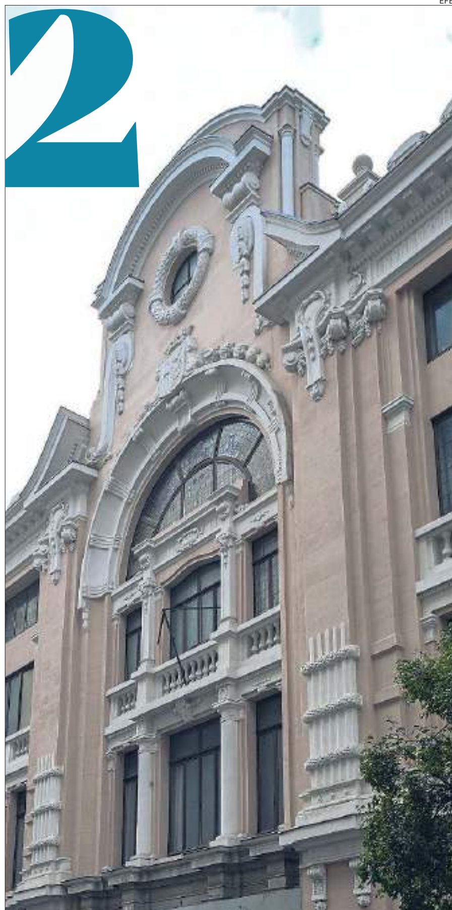
Fachada del Edificio Medinaceli, donde se instalará la colección de Francesca Thyssen
